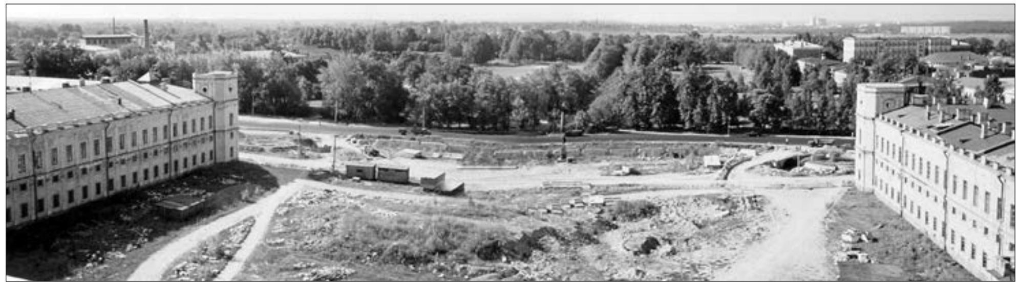
Гатчинский дворец. 1978 г. Работы по реконструкции дворцового плаца. Фото Владислава Циунелиса
